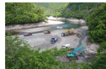
▲堆砂除去状況（平谷箇所）
