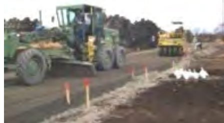
丁張りによる施工
