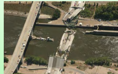
【ミシシッピ川に係る高速道路橋の落橋事故 (2007年米ミネソタ州)】(出典:MN/DOT)
