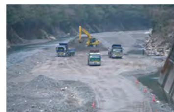
▲堆砂除去状況（十二社箇所）
