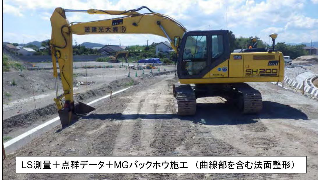
法面整形状況写真
