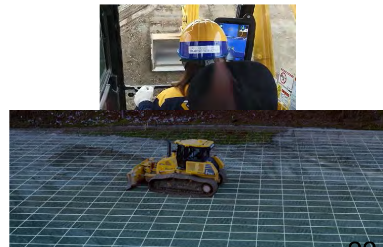
ICT建機による施工
